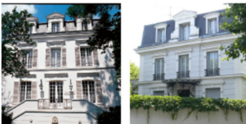
Source : Charte de ravalement, CAUE 94, 2010
