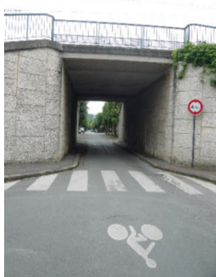
Passage sous la voie ferrée, une porte d'entrée vers un autre quartier
