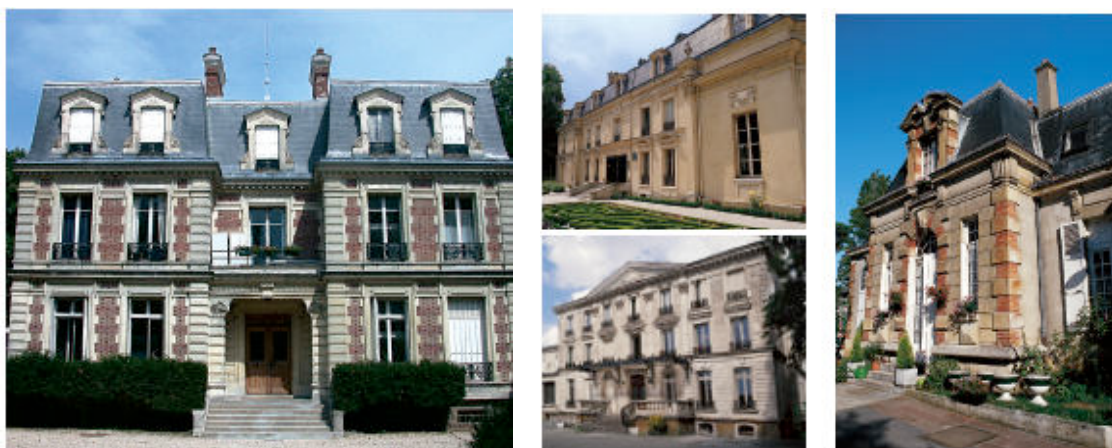
Source : Charte de ravalement, CAUE 94, 2010
