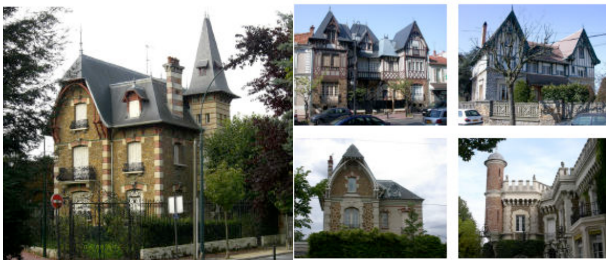
Source : Charte de ravalement, CAUE 94, 2010
