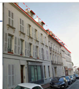
Rue du Four
