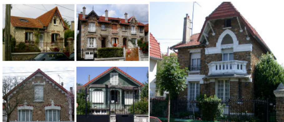
Source : Charte de ravalement, CAUE 94, 2010
