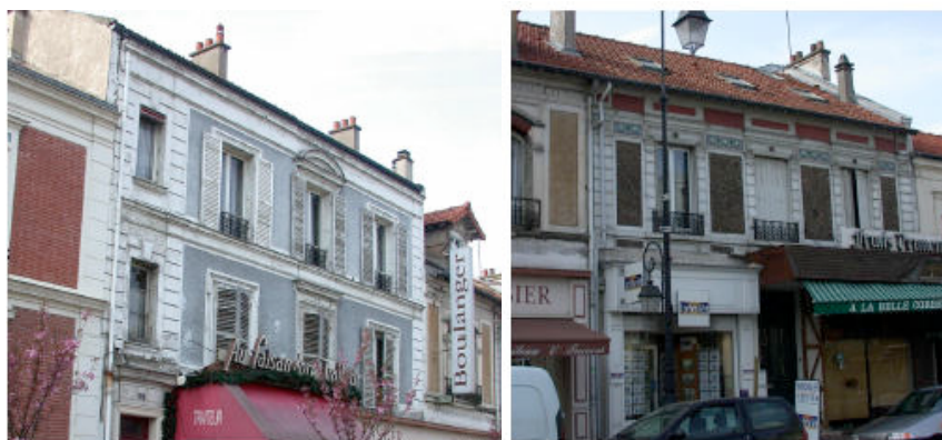
Source : Charte de ravalement, CAUE 94, 2010
