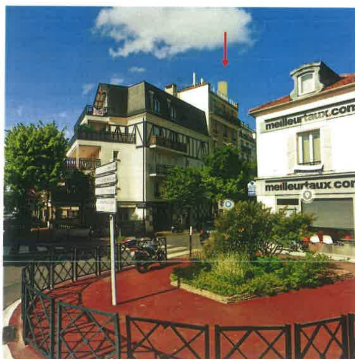
Photographies : Vue 1- Après Travaux
