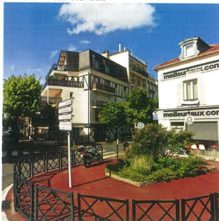
Photographies : Vue 1- Avant Travaux
